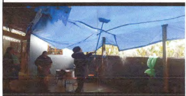
Foto 2: reparacion de muro perimetral
