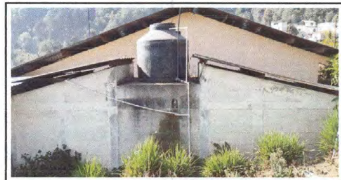
Foto 6: cambio de deposito rotoplas de 1100 lts
