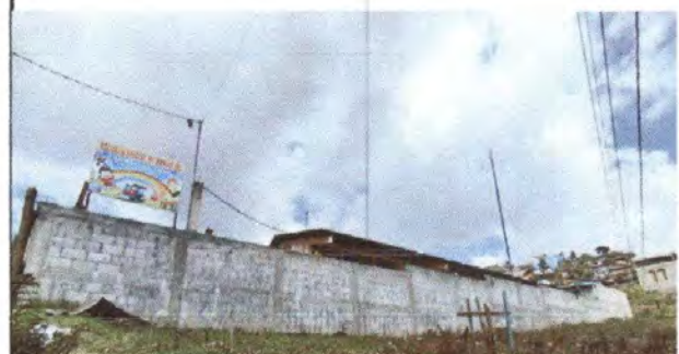
Foto 4: repello en muro perimetral
