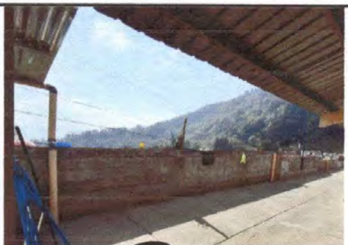
Foto 9: repello parte interior muro perimetral y reparacion de tubo hg y malla galvanizada
