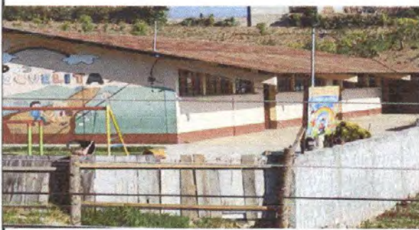
Foto 3: lijado cepillado y aplicacion de pintura modulo de techo
