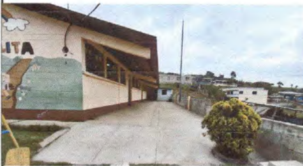
Foto 1: extension de lamina troquelada modulo de patio Y Sustitucion de canla pvc
