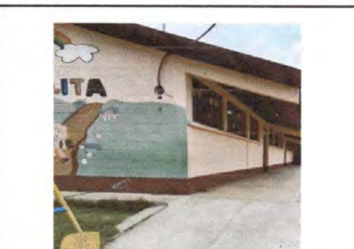
Foto 11: pintura en parte exterior y interior
