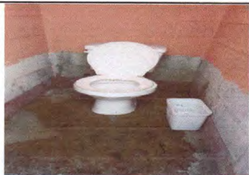
Foto 7: cambio de tazas sanitarias
