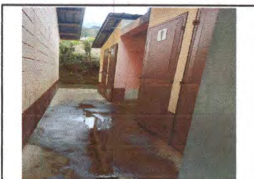
Foto 10: pintura paredes de modulo sanitarios.
